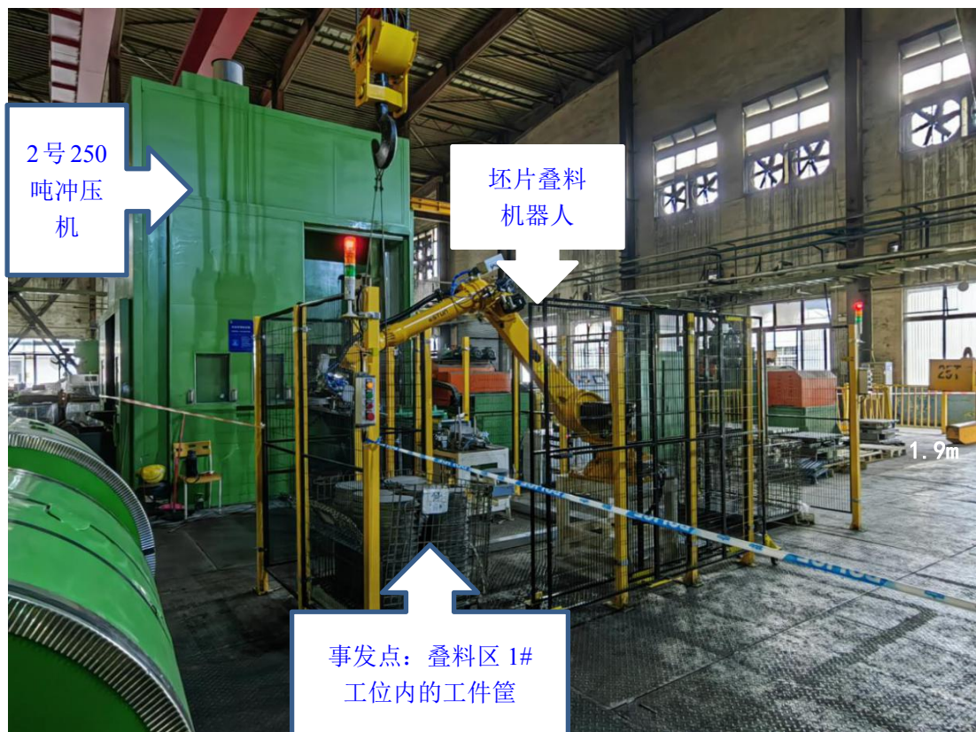
图 1 事故现场情况
