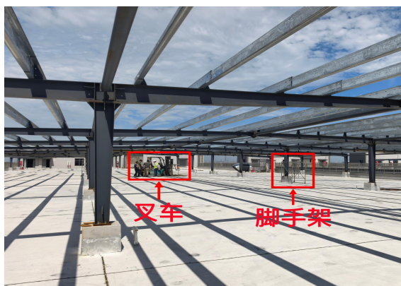
图 1 施工现场总览图
