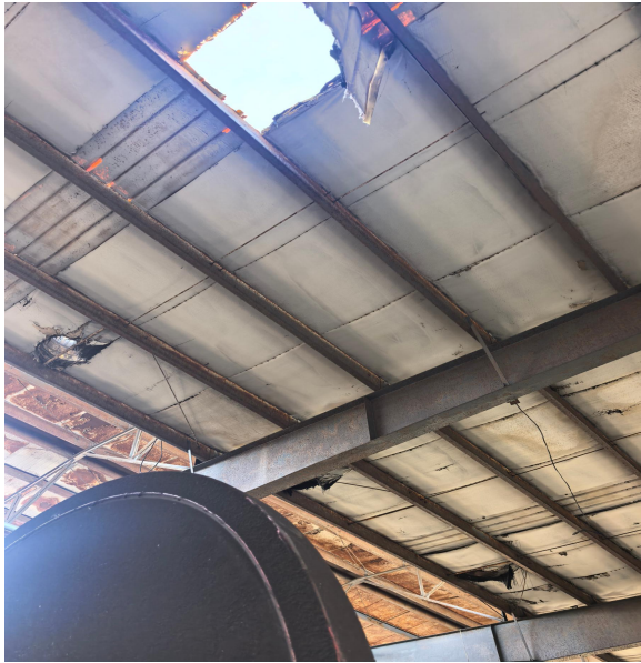
图3 厂房内部磨砂轮现场图
