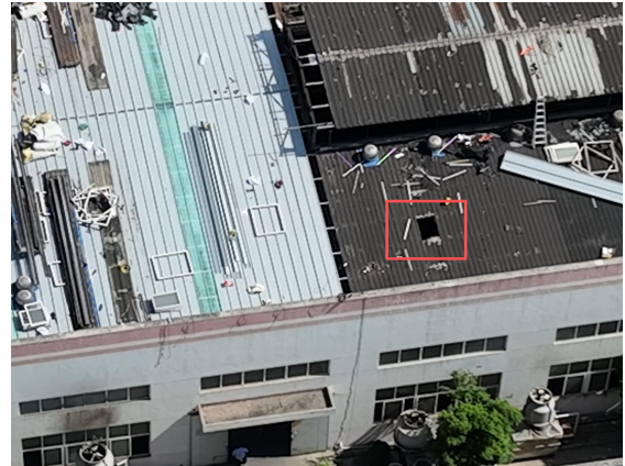
图 2 破损采光带位置示意图
