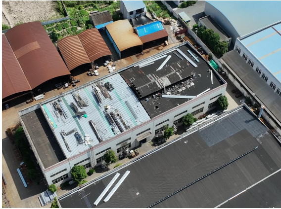
图 1 施工现场总览图
