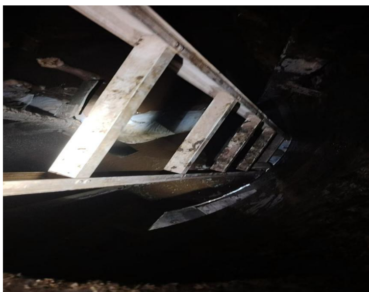
图5 事故设备内部图
