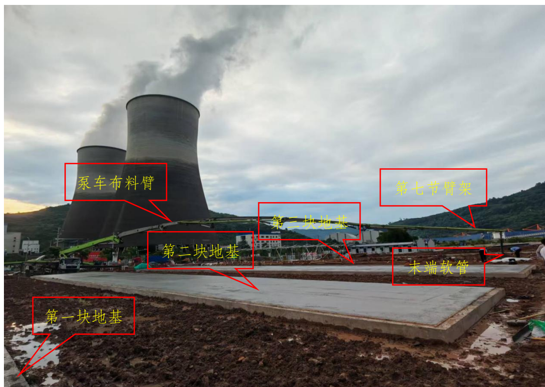
图 1（临建工程现场正视图）
