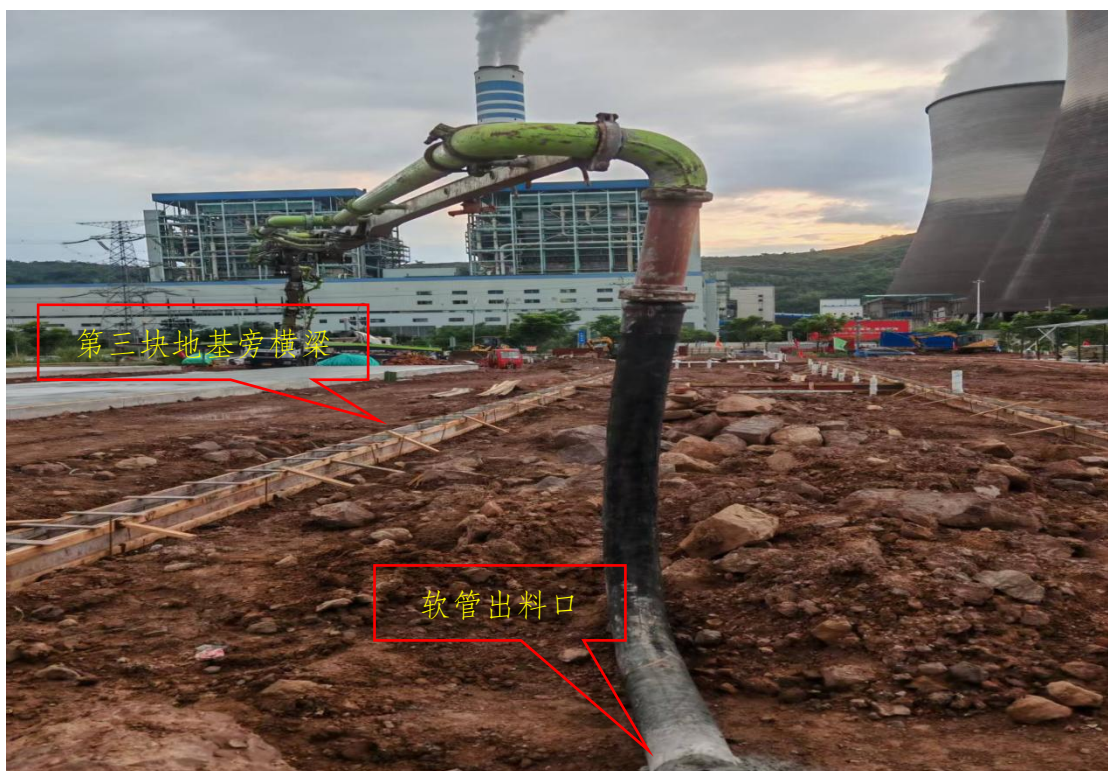
图 2（泵车布料臂末端正视图）
