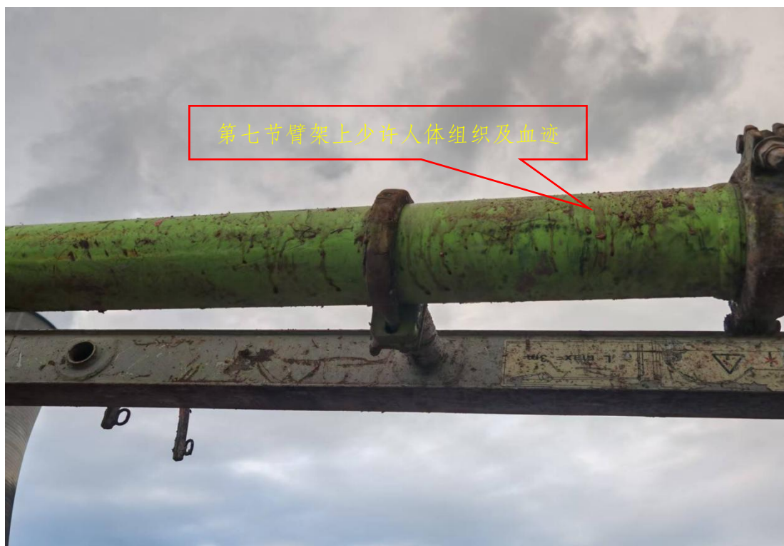
图 4（谢某某、冉某某被第七节臂架打击处）
