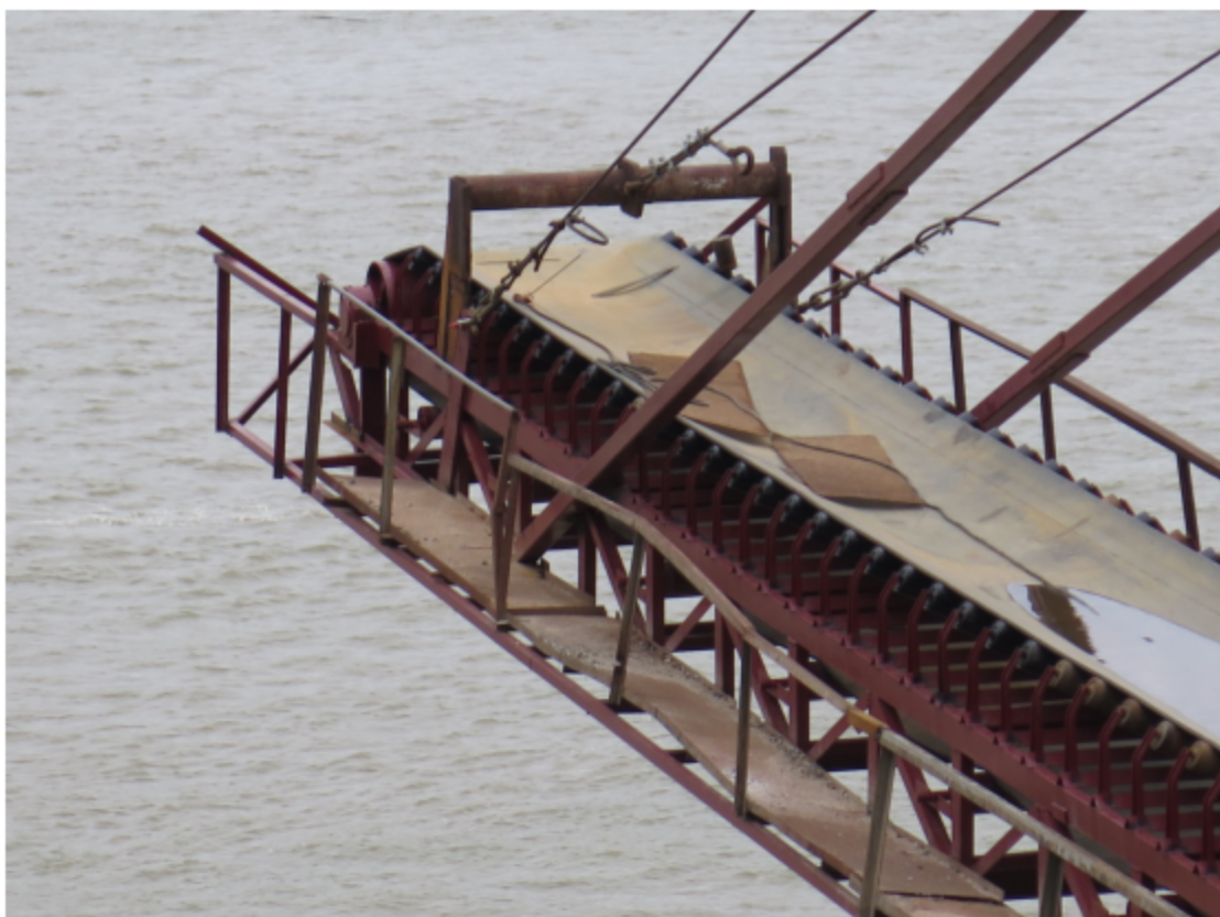
(何*清在 2#输送架前端使用的电焊作业工具及作业点)
