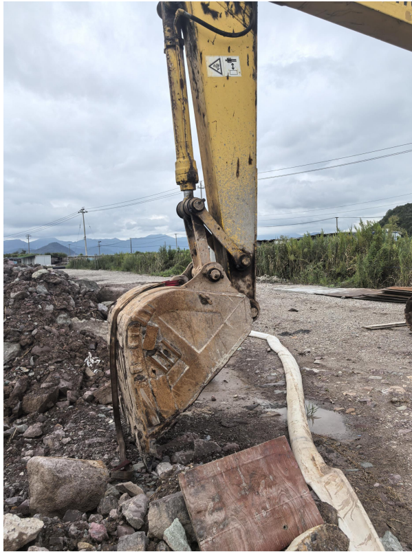
图 3 事故现场挖掘机图片
