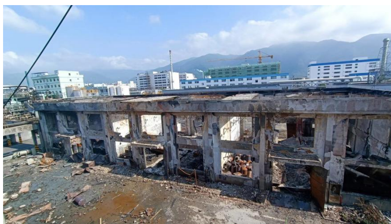
上图为事故后的 T10 危废仓库（甲类）
