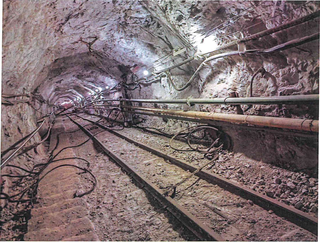
照片 8 断裂的捞车器钢丝绳
