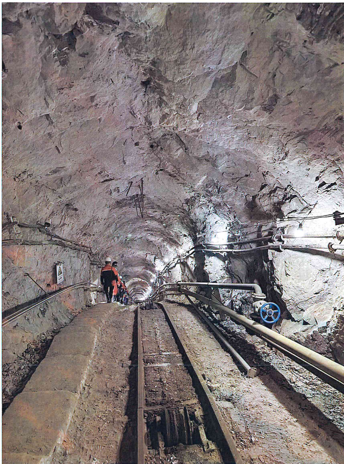
照片 7 盲斜井起坡处（阻车器）
