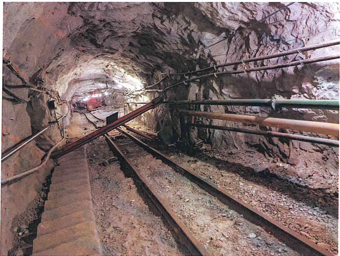
照片 9 断裂的捞车器横梁
