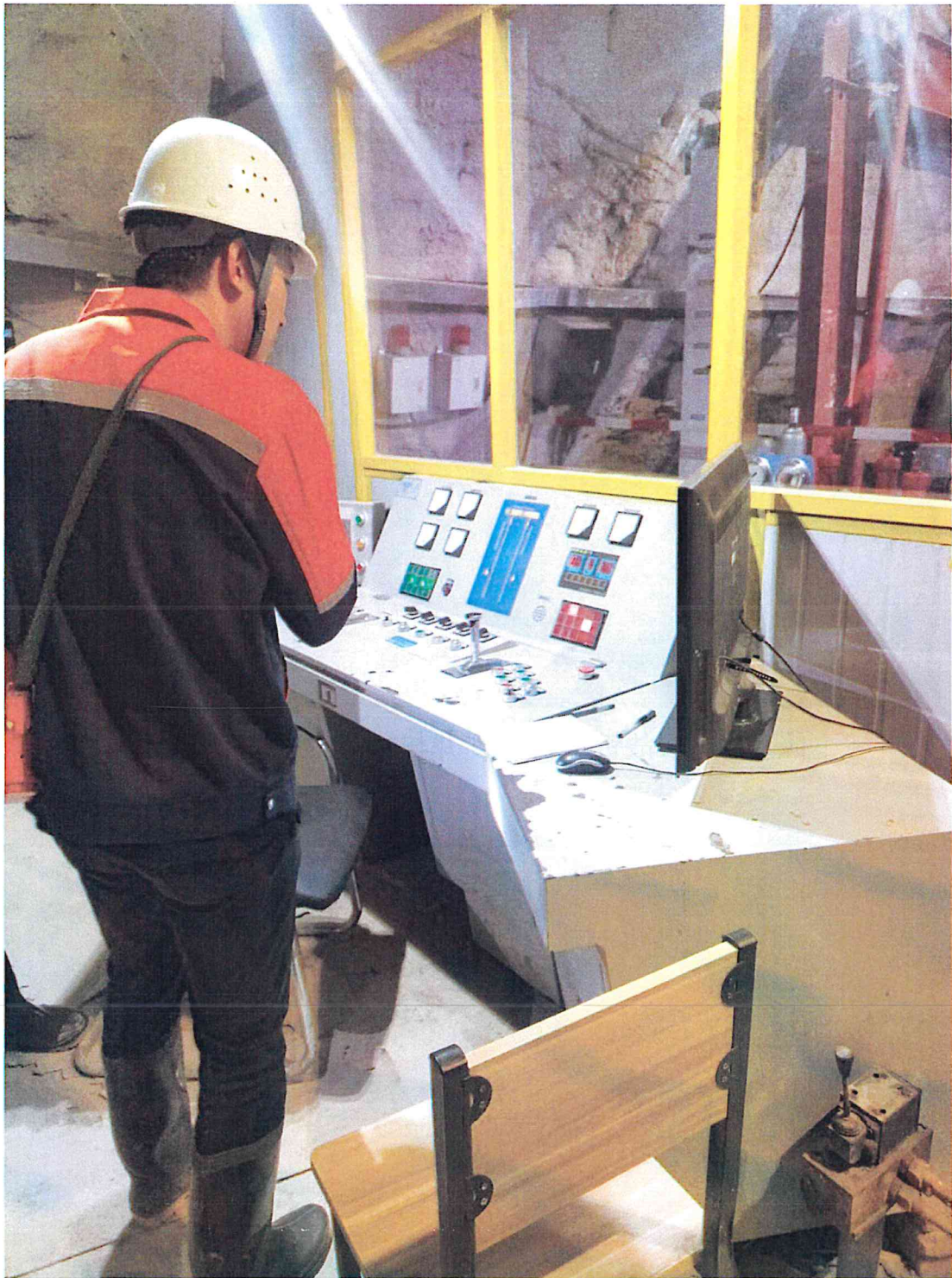
照片 5 卷扬机控制室
