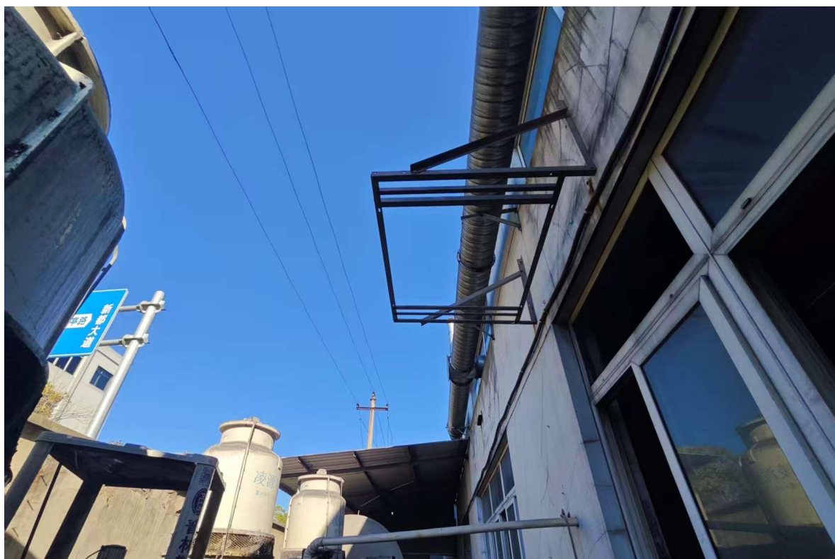
图 4 厂房北侧外墙支架
