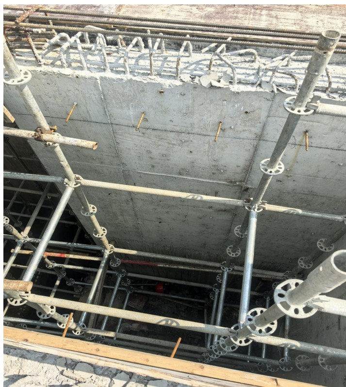
图 3：事故发生点泵房提升井
