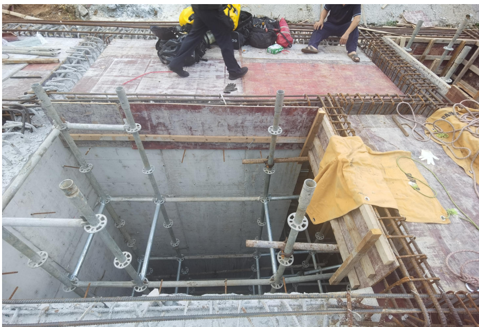
图 2：事故发生点泵房提升井
