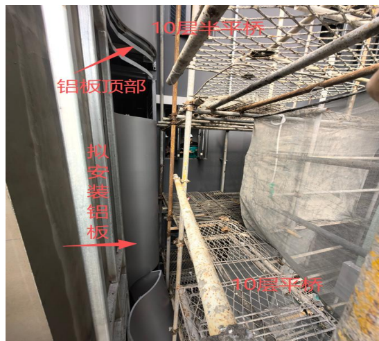
图 7 事发时拟安装铝板放置情况
