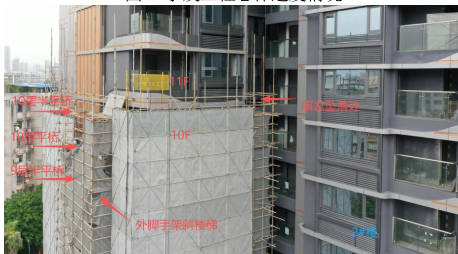
图2 1#楼外脚手架拆除情况
