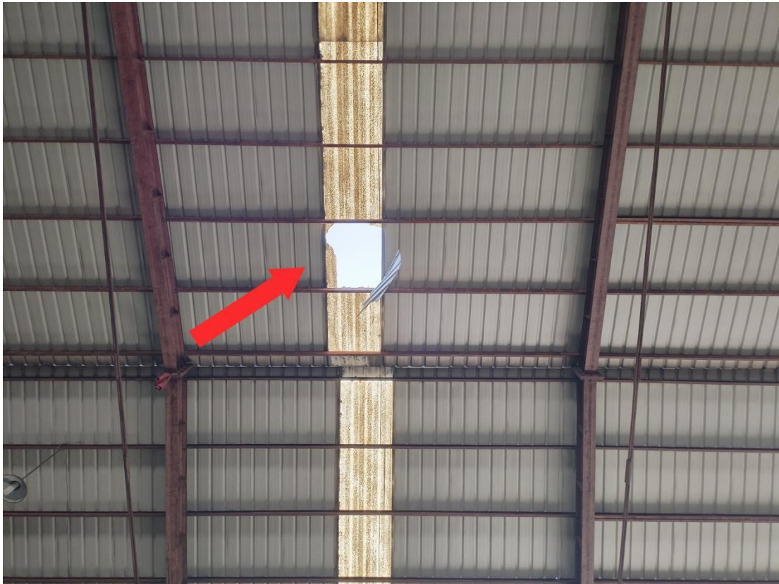
图 1：屋顶破洞图
